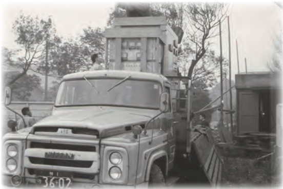
電子計算機が搬入された日（昭和41年）
